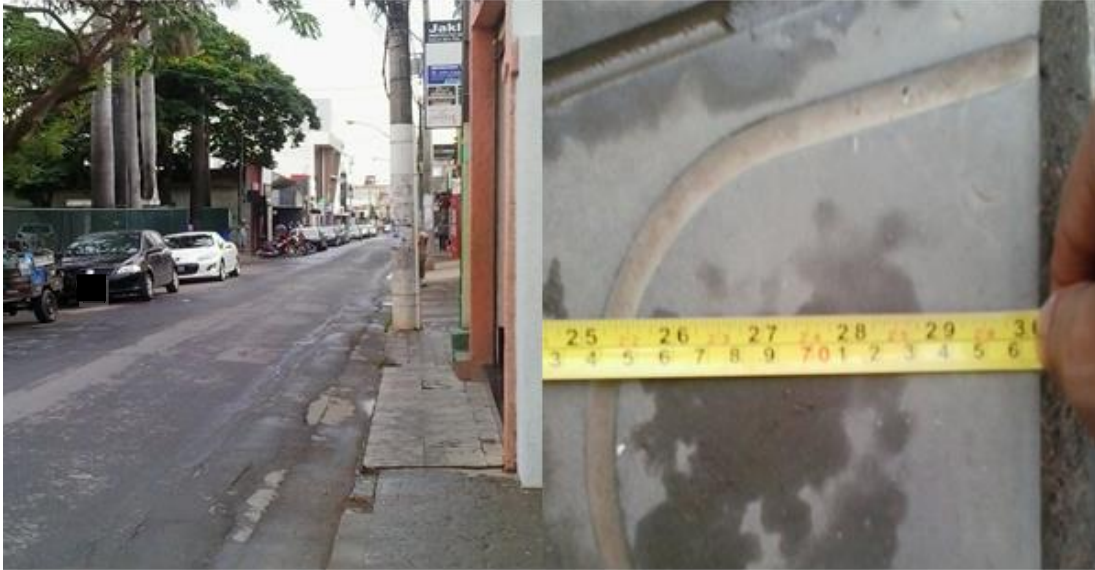
Figura 4 – Trecho da rua Dr. Veloso em frente o Hospital FAMED – 21/10/14
