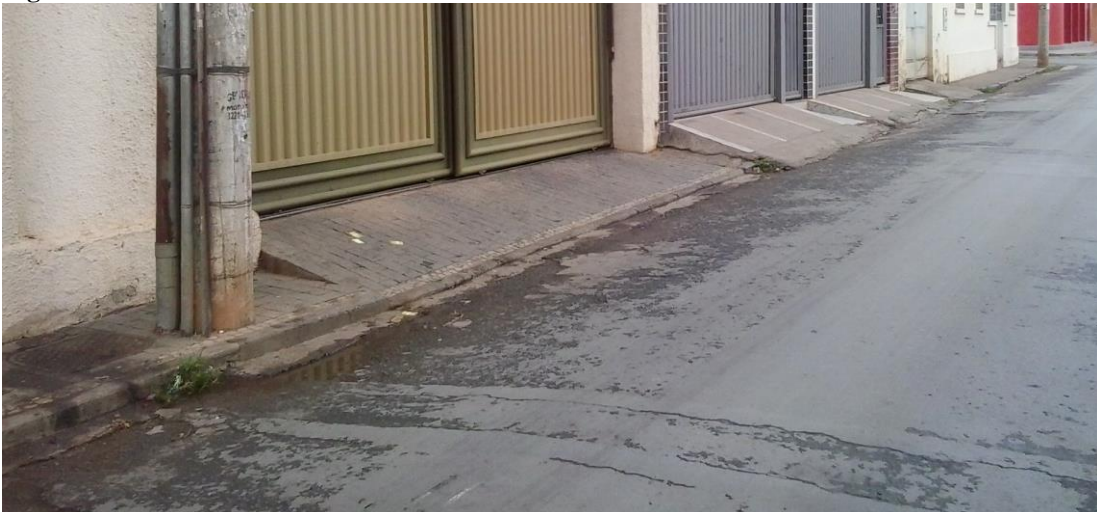
Figura 3 – Trecho da rua Dr. Veloso entre Rua Januária e General Carneiro – 21/10/14
